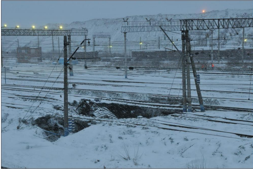
Рис. 2. Провал, образовавшийся под действующей железной дорогой, расположенной над горными выработками в г. Березники Пермского края
