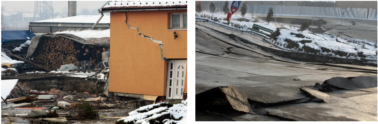
Рис. 3. Обрушения земной поверхности в зоне влияния отработанной соленой шахты в Румынии
