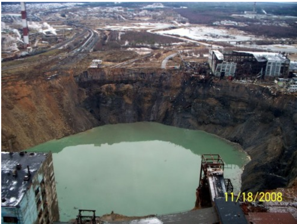
Рис. 1. Провал, образовавшийся над горными выработками в городе Березники Пермского края
