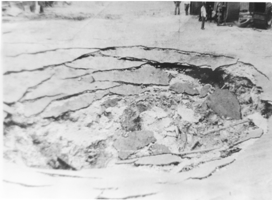
Рис. 1. Обрушение поверхности над заброшенным наклонным стволом шх. Острая № 2 ПО «Селидовуголь»
