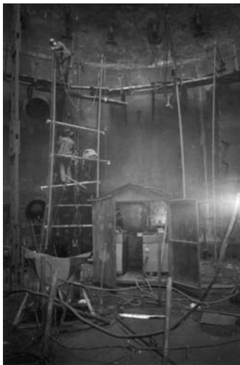
Рис. 1. Электрошлаковая сварка вертикального стыка монтажных блоков (вид с монтажной подвесной площадки, расположенной внутри кожуха домы)
