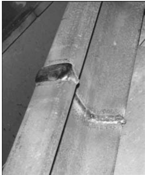
Рис. 2. Стыковое соединение рельсов из стали типа Р-65, выполненное электродуговой сваркой закладным электродом
