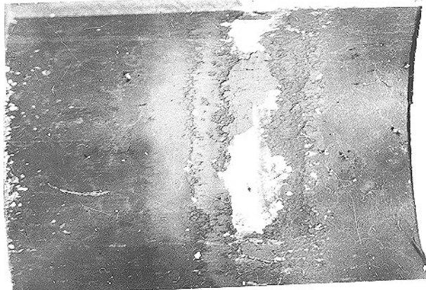
Рис. 8. Внешний вид внутренней поверхности трубы на участке, соответствующем положению дистанционирующей решетки после 16 лет эксплуатации
