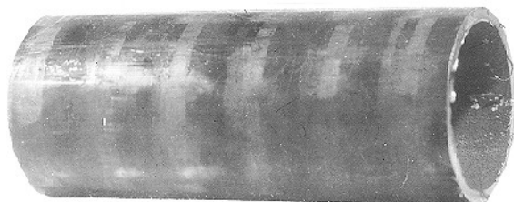
Рис. 2. Вид поверхности патрубков центральной части ТК после 16 лет эксплуатации
