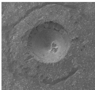
Рис. 8. Растрескивание покрытия без разрушения
