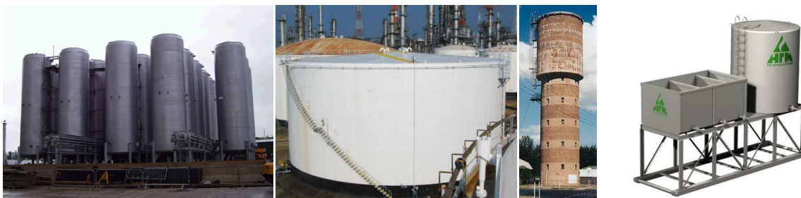
Рис. 1. Приклади вертикальних циліндричних баків-резервуарів для збереження великих об'ємів рідини
