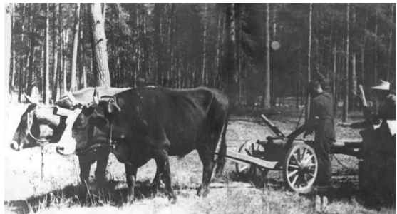
Мала механізація для монтажу дерев'яних опор
