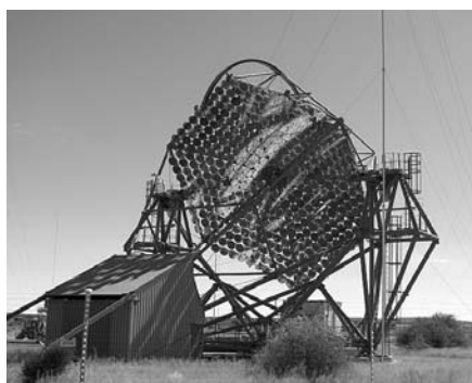
Рис. 4. Один із черенковських телескопів стереоскопічної системи H.E.S.S. (світлина М.Дирди, Намібія, травень 2009).
