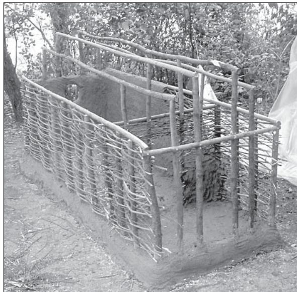
Рис. 1. Процес зведення експериментальної моделі житла трипільської культури
