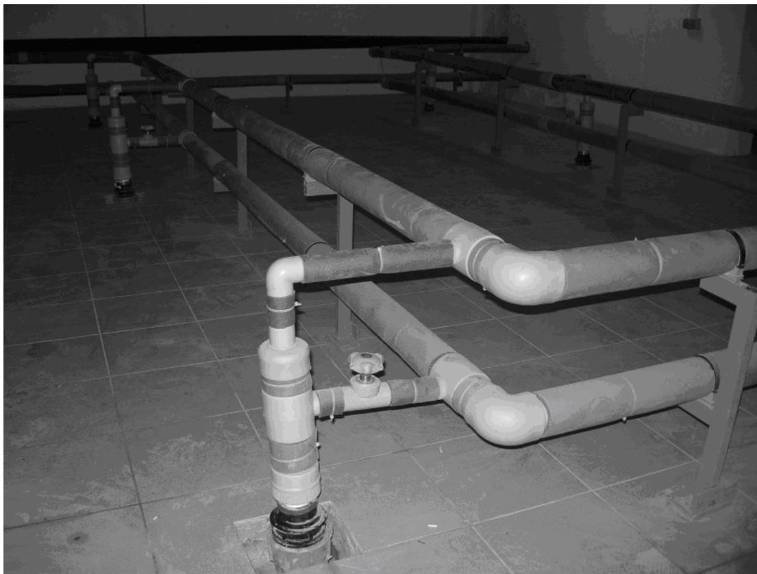
*Рис. 1. Участок вертикального грунтового аккумулятора в подвале здания.*
