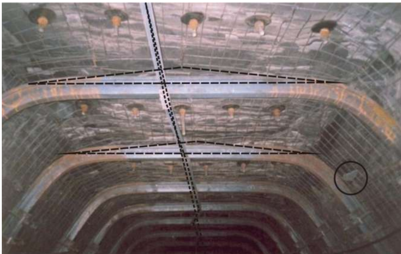
Рисунок 2 - Пример обработки фотоизображения с помощью методики визуального контроля
