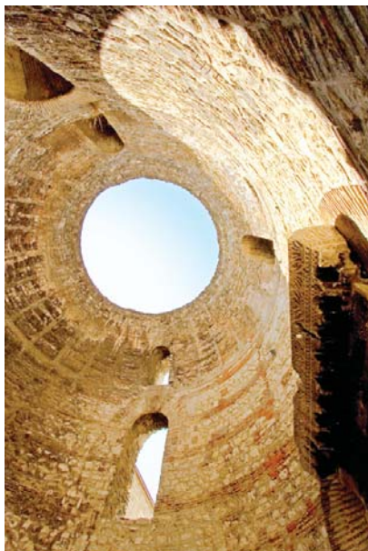
Рис. 12. Палац Діоклетіана у Спліті. Конструкція купола вестибюля
