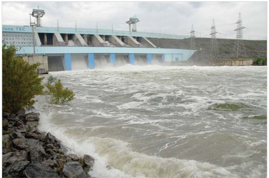
Днестровская ГЭС, пропуск паводка
