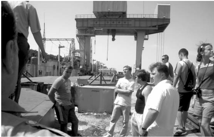
Монтажний майданчик Київської ГАЕС
