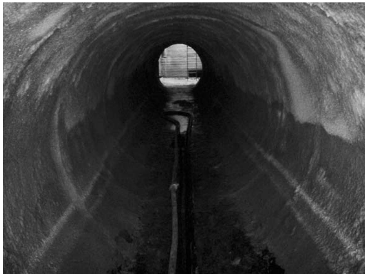
Рис. 4 - Вид участка трубы водопроводящего сооружения после выполнения ремонтных работ
