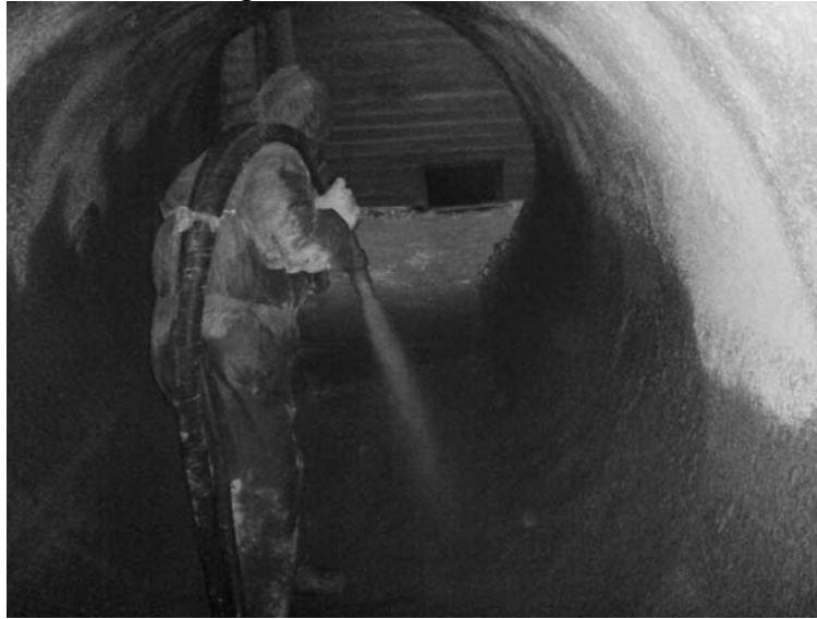
Рис. 3 - Нанесение защитного гидроизоляционного покрытия
