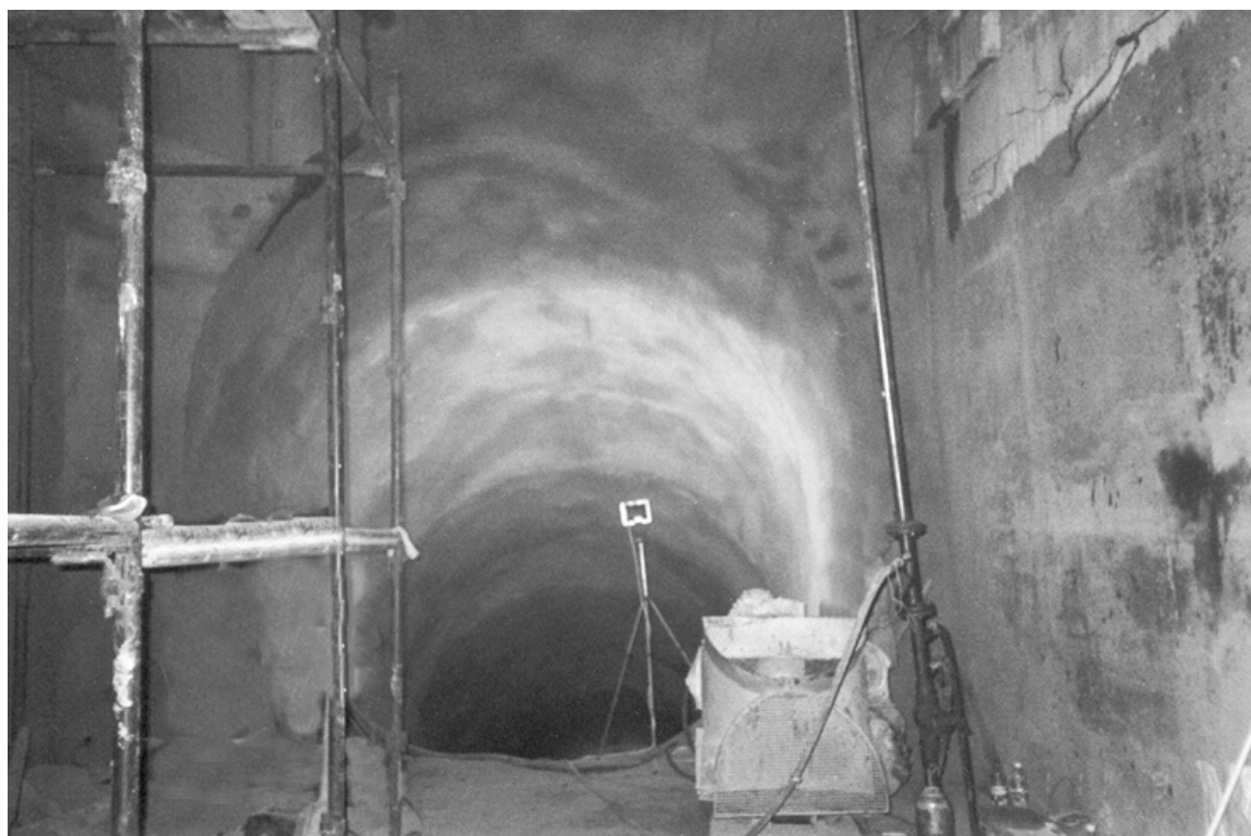
Рис. 1 - Вид вентиляционного канала на сопряжении с вентиляционной камерой
