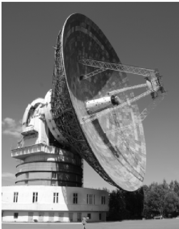
Радиотелескоп с двухзеркальной антенной с профилированными зеркалами ТНА-1500 (полигон ОКБ МЭИ в п. Медвежье Озера)
