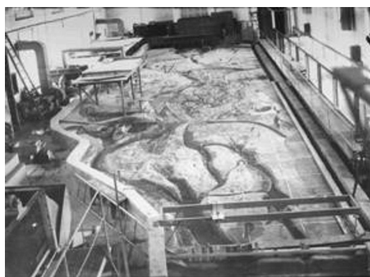
Рис. 3. Вигляд гідравлічної лабораторії ІГМ НАН України з моделями київської ділянки Дніпра (1963 р., аеродинамічний стенд ліворуч на другому плані)
