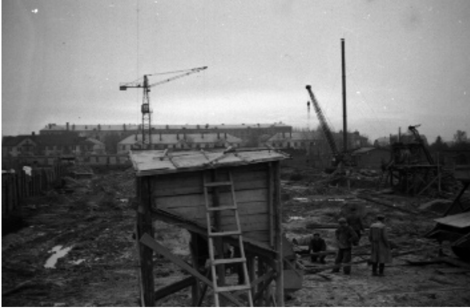
Загальний вигляд будівельного майданчика під спорудження будинку центрального архіву України. Київ, листопад 1960 р. (ЦДКФФА України ім. Г. С. Пшеничного, од. обл. 0-70440)
