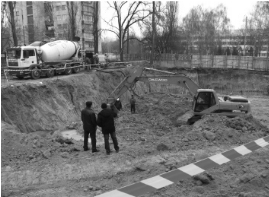
Загальний вигляд котловану під фундамент першого корпусу. Грудень 2007 р.
