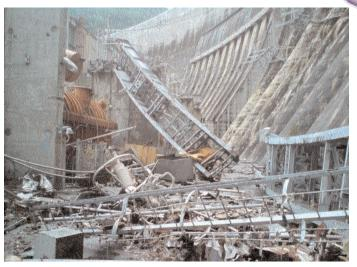
жена, что чревато обрывом крышки турбины от действия на нее гидродинамических усилий со стороны проточной части турбины со всеми вытекающими отсюда последствиями (затоплением здания ГЭС и т. д.).
