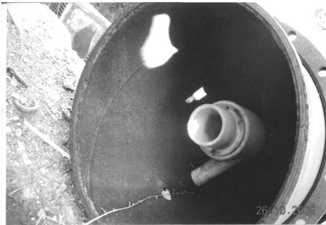
Рис. 2 – Внешний вид эжекторного устройства типа ЭПВ
