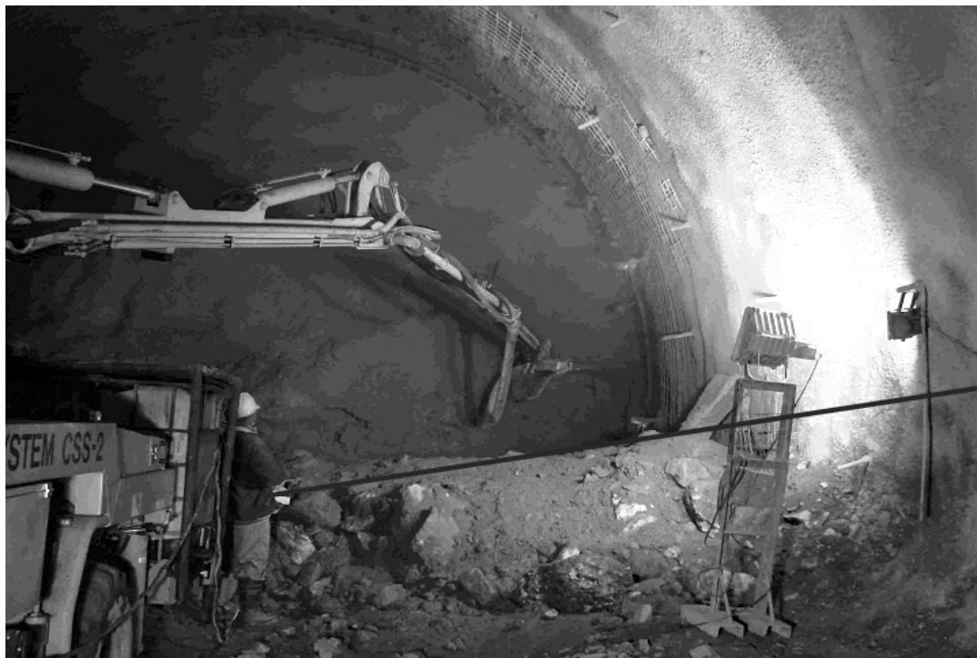
Рис. – 4 Пример автоматизации набрызгбетонных работ
