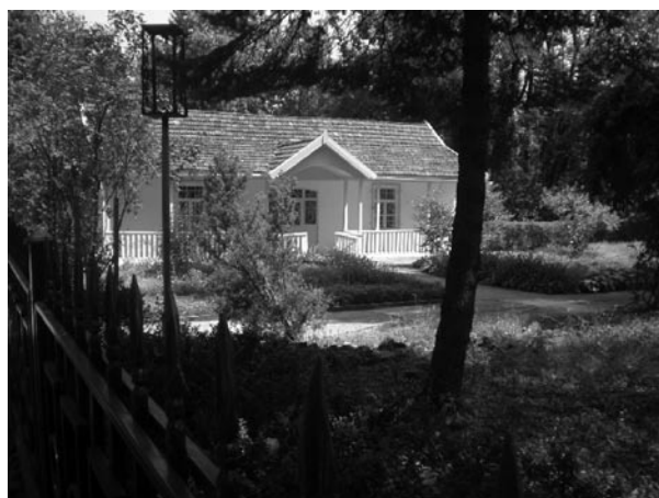
Фото 7. Будинок-музей Марка Вовчка після ремонту (фото автора статті у серпні 2010 р.)
