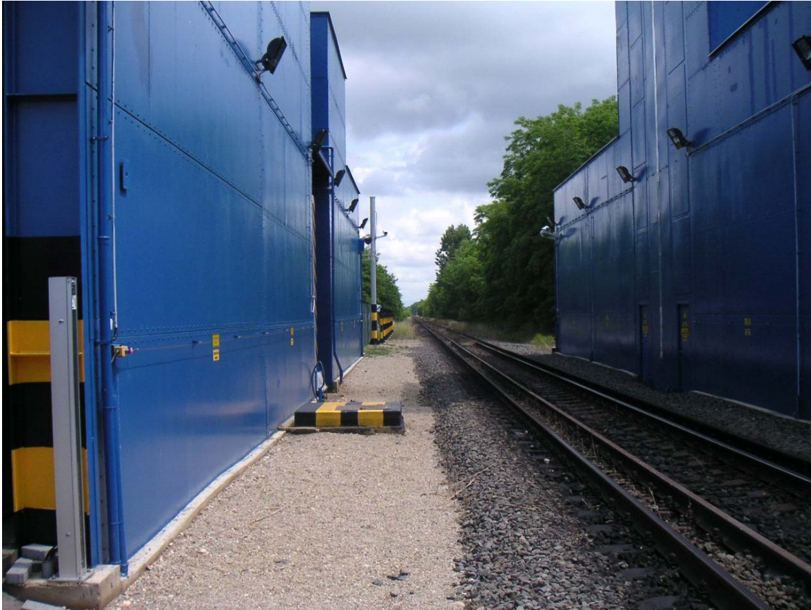
Рис. Фото рентгеновського сканера TNSCAN RF6010 китайського виробництва для догляду вантажних вагонів на прикордонній станції Ужгород-2 - станції Матевце в Словачії
