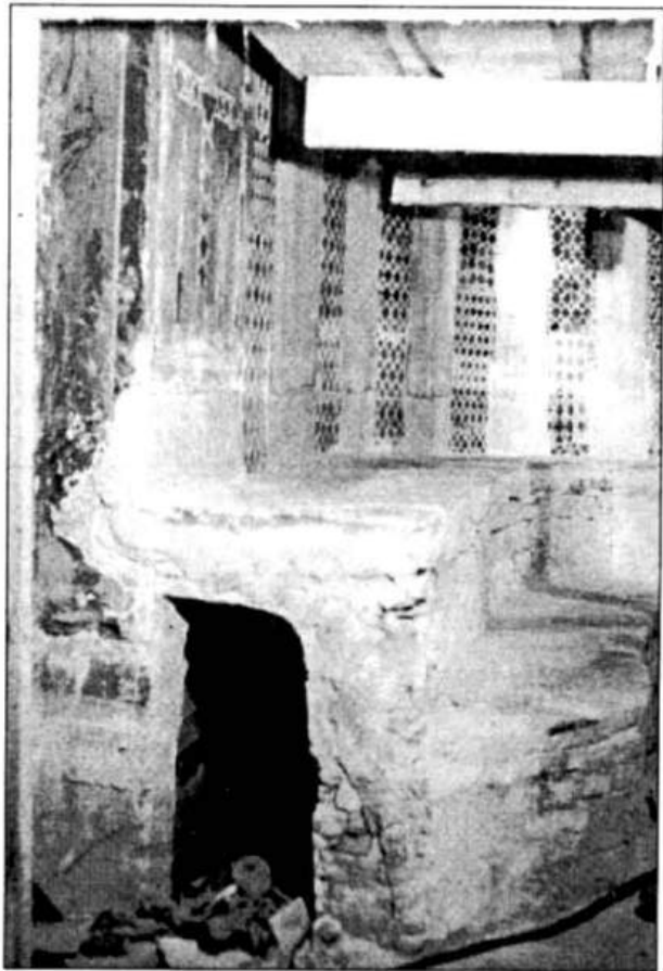
Рис. 2. Північна частина синтрону після зняття пізніх на шарувань.
