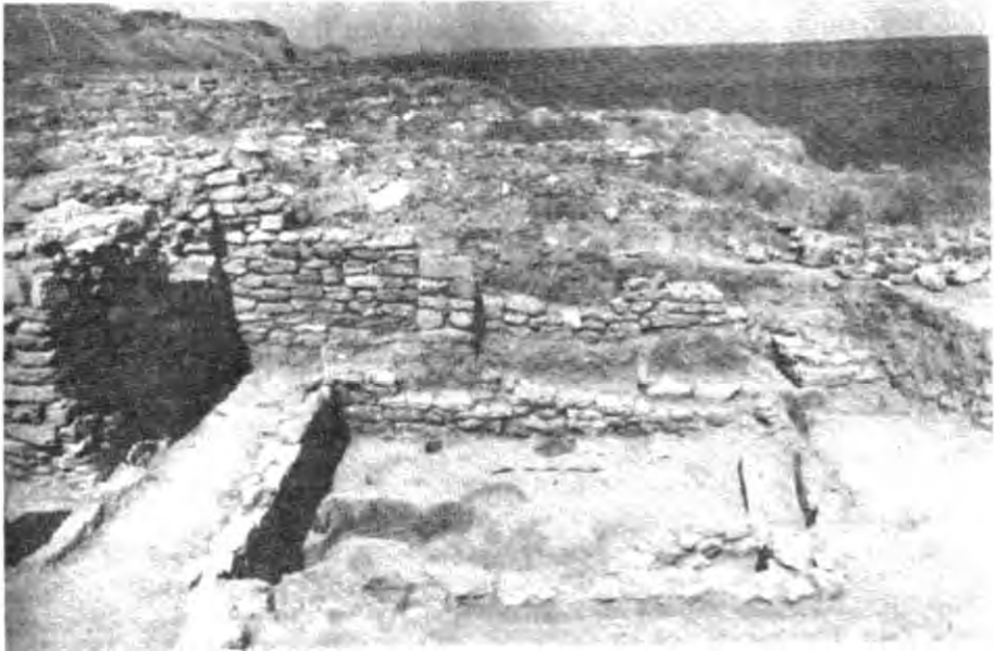
Рис. 10. Ділянка НГС. Будівельні залишки IV—III ст. до н. е. Вигляд з півдня. Розкопки Н. О. Лейпунської, Т. Л. Самойлової (з Наукового архіву ІА НАНУ).
