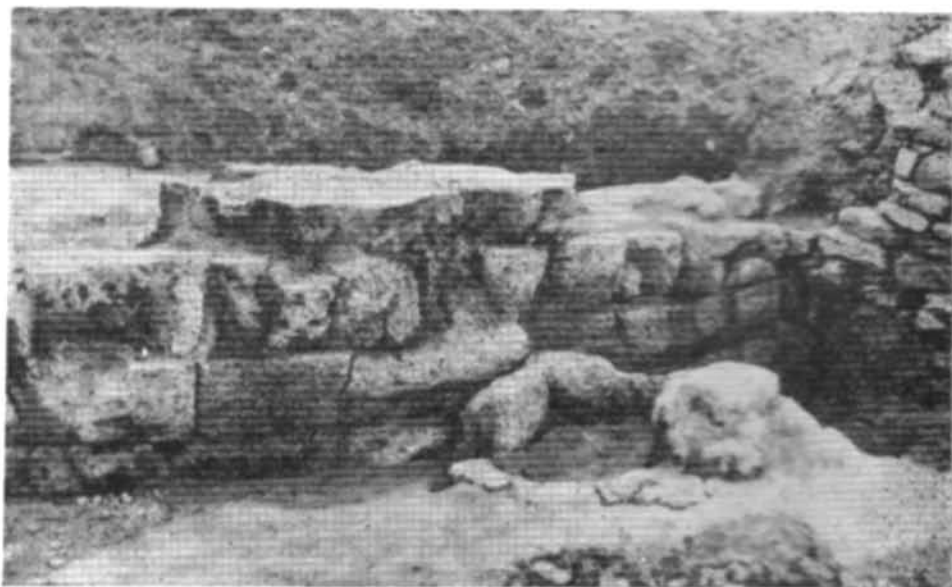
Рис. 9. Оборонна вежа. Фрагмент північного фасаду.
