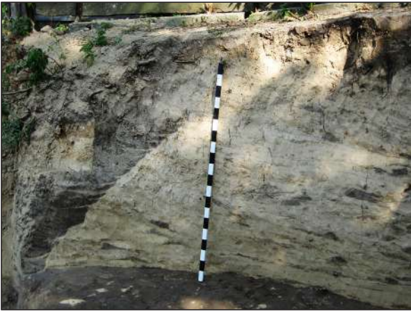
Рис. 6. Заповнення тіла апарелі (підйому на лунет). Конструктивні особливості насипу лунета (сліди терасування північного схилу перед насипанням апарелі). Вигляд із заходу
