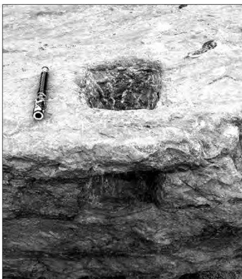
Рис. 5. Отверстие для швартовки
