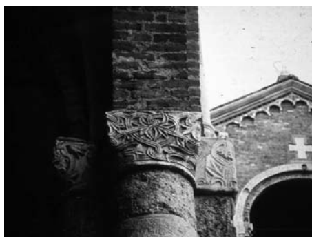
39. Чернигов. Борисоглебский собор. Завершающая часть фасадной полуколонны с белокаменной капителью
