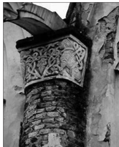
38. Чернигов. Борисоглебский собор. Завершающая часть фасадной полуколонны с белокаменной капителью
