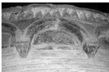
17. Чернигов. Успенский собор Елецкого монастыря. Фрагмент кладки аркатурного пояса
