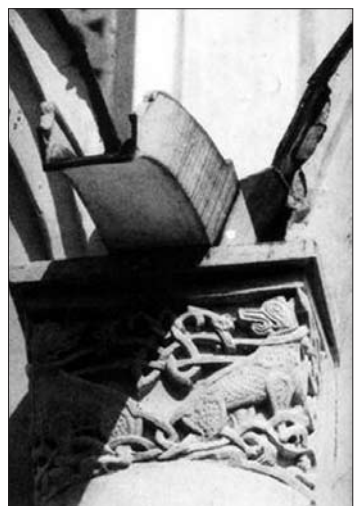
35. Чернигов. Борисоглебский собор. Завершающая часть фасадной полуколонны с белокаменной капителью
