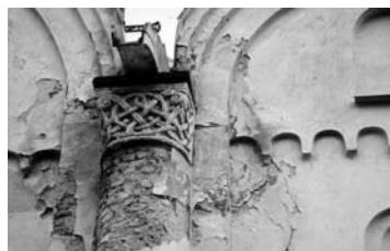
37. Чернигов. Борисоглебский собор. Завершающая часть фасадной полуколонны с белокаменной капителью
