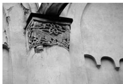
36. Чернигов. Борисоглебский собор. Завершающая часть фасадной полуколонны с белокаменной капителью
