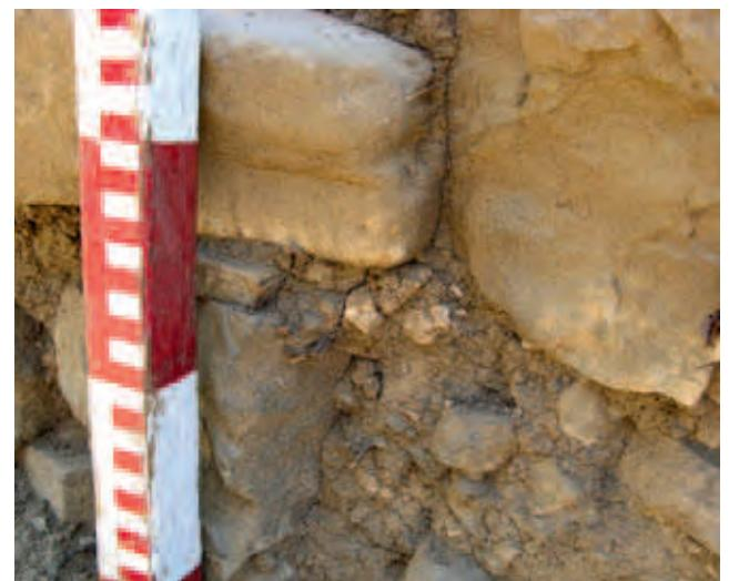
Рис. 1.24. Северный вход в храм. Фрагмент. Шов между кладками первого и третьего строительных периодов, остатки известковой штукатурки на восточном откосе проёма. Вид с запада.
