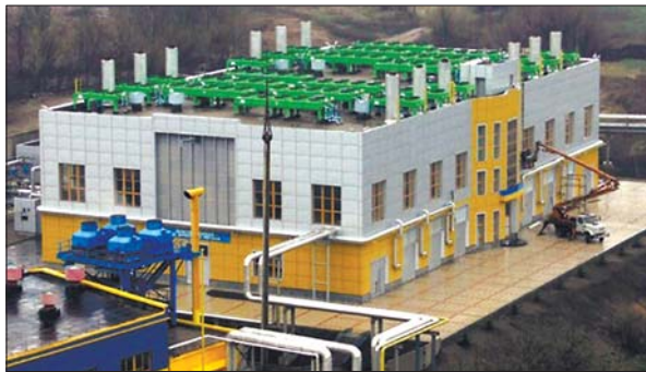
Теплоенергетичний комплекс на ПАТ «Шахта ім. О.Ф. Засядька». Розробка Інституту геотехнічної механіки ім. М.С. Полякова НАН України
