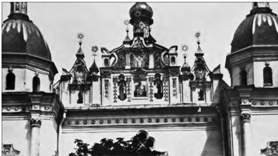
Рис. 3. Микільський собор Києва 1696 р. з низкою керамічних розеток на фризі антаблементу. Світлина до зруйнування храму 1934 р. Фотоархів С. Таранушенка, Національна бібліотека України в Києві
