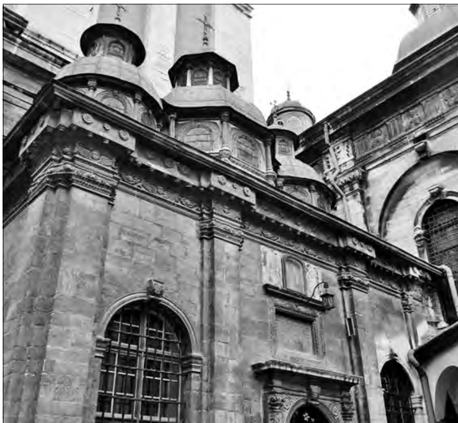
Рис. 8. Різьблені кам'яні квіткоподібні розетки на фризі під карнизом каплиці Трьох Святителів 1578 р. у Львові
