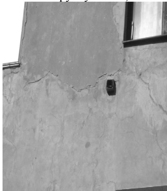
Фото 4. Опорный элемент тяжа на восточном фасаде дома по бул. Пушкина, 7
