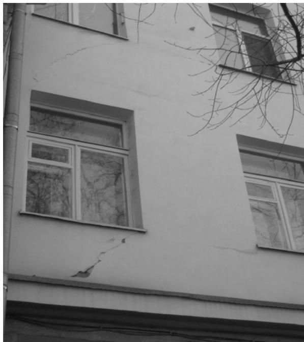
Фото 3. Косая трещина на западном фасаде дома по бульвару Пушкина, 13
