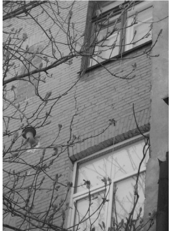
Фото 2. Вертикальная трещин (до 20 мм) на южном фасаде дома по бульвару Пушкина, 13
