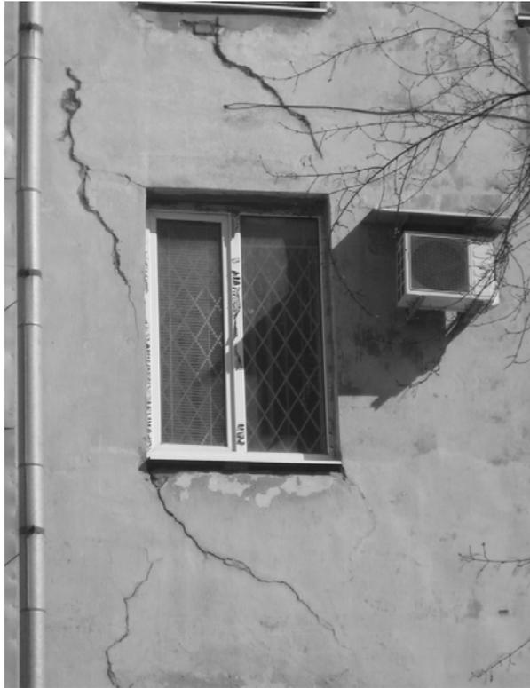
Фото 1. Сеть трещин (25 мм) на южном фасаде дома по бульвару Пушкина, 13
