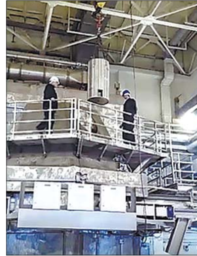
Рис. 5. Процес завантаження першої тепловидільної збірки до активної зони ЯПУ «Джерело нейтронів». 27 липня 2020 р.
