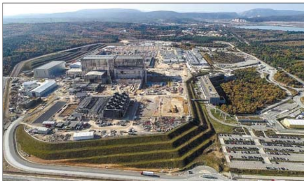
Будівельний майданчик ITER з висоти пташиного польоту. Січень 2021 р. (джерело: www.iter.org )
