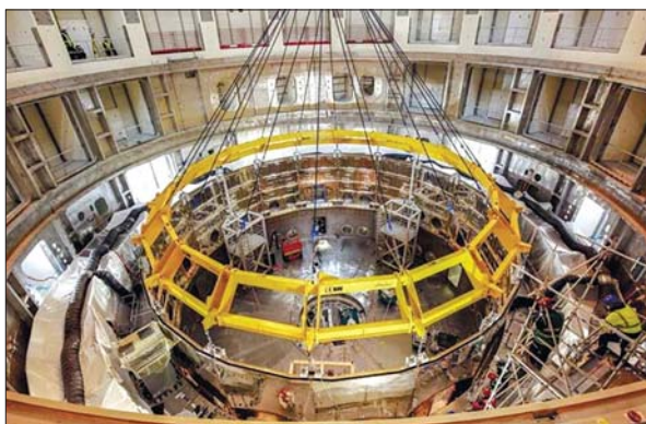
Монтажні роботи зі зведення корпусу реактора ITER (джерело: www.iter.org )
