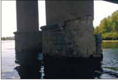
Вивали фрагментів кам'яної кладки опори № 21
