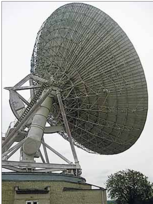
Рис. 1. Променевід антени MARK-4B спрямовує сигнали всіх частот в одну точку в апаратному приміщенні
