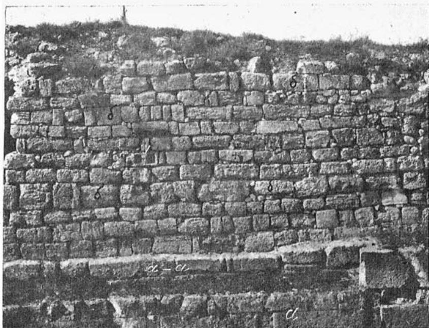
Рис. 22. Кладка 16 куртины, отрезок 10 (внутренняя часть): a —кордонная кладка I яруса (IV века до н. э.); a—a —часть кладки II яруса (вторично использованные кордонные камни из кладки I яруса); б —кладка III яруса византийской эпохи V—VII века; х —изображение креста ранней формы на камне, использованном вторично; у —камень с двумя углублениями.
