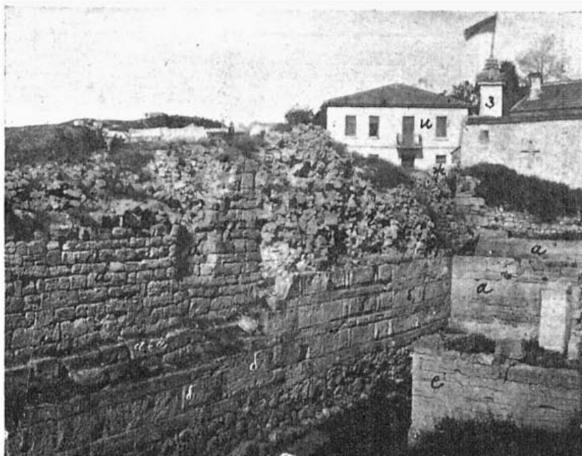
Рис. 21. Вид внутренней части 16 куртины со стороны города: а — два пилона ворот древнегреческого времени; б — I ярус 16 куртины. Кладка кордоном на ребро, плитами на образок. Стена стоит на бутовом фундаменте; б 1 — часть той же стены со стесанными рустами, так как в этом месте в позднейшую эпоху была устроена цистерна и стена города служила одной стеной цистерны; г — бут, уцелевший от разобранной кладки византийского здания, с цистерной в нем. Здание непосредственно примыкало к оборонительной стене (след от дома, пристроенного к стене); д — кладка стены III яруса с углублением хозяйственного назначения (след от дома, пристроенного к стене); е — древнегреческое здание у ворот (казарма?); ж — византийская калитка над древнегреческими воротами; з, и — ворота и б. монастырская гостиница.
