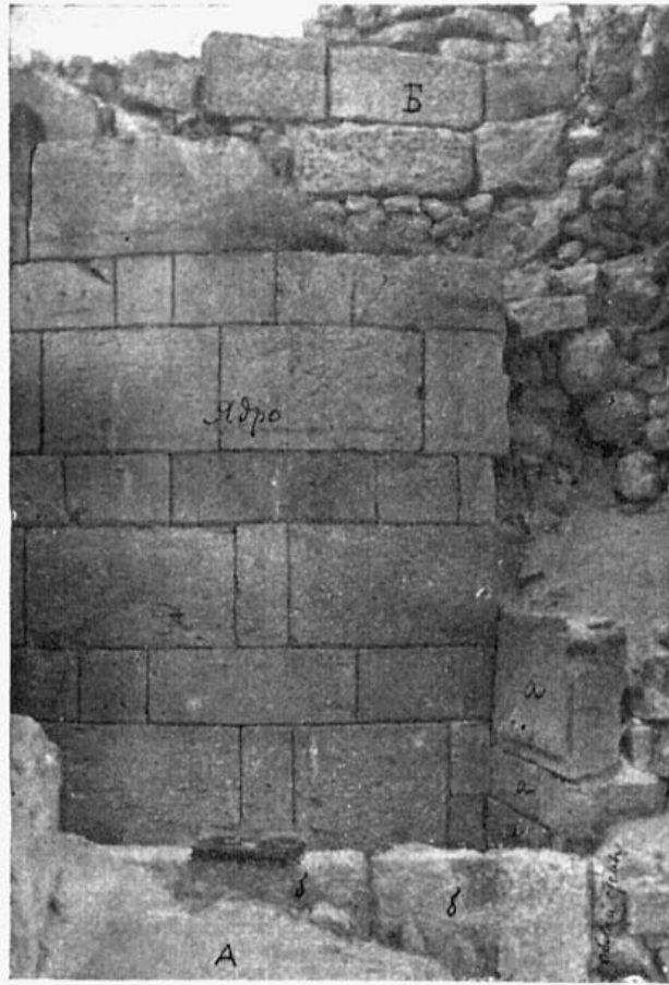
Рис. 63. Кладка древнегреческого ядра башни Зенона с остатком а кладки II стены 20 куртины; б —облицовка I кольца; А —начало III стены 20 куртины.
