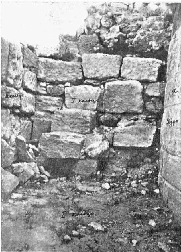
Рис. 67. Кладка I кольца башни Зенона. Вид с юга.
