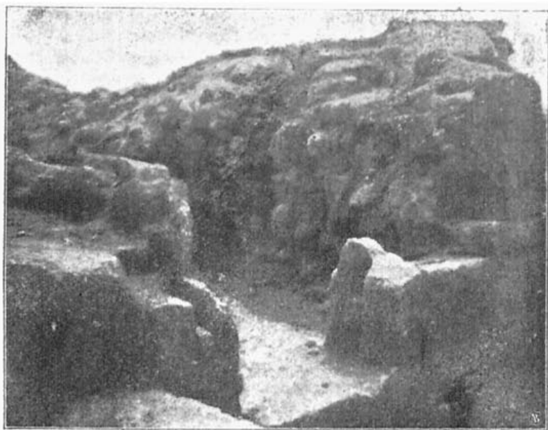
Рис. 83. Порог калитки 2-го яруса кладки 19 куртины. Вид с башни № XVI.
