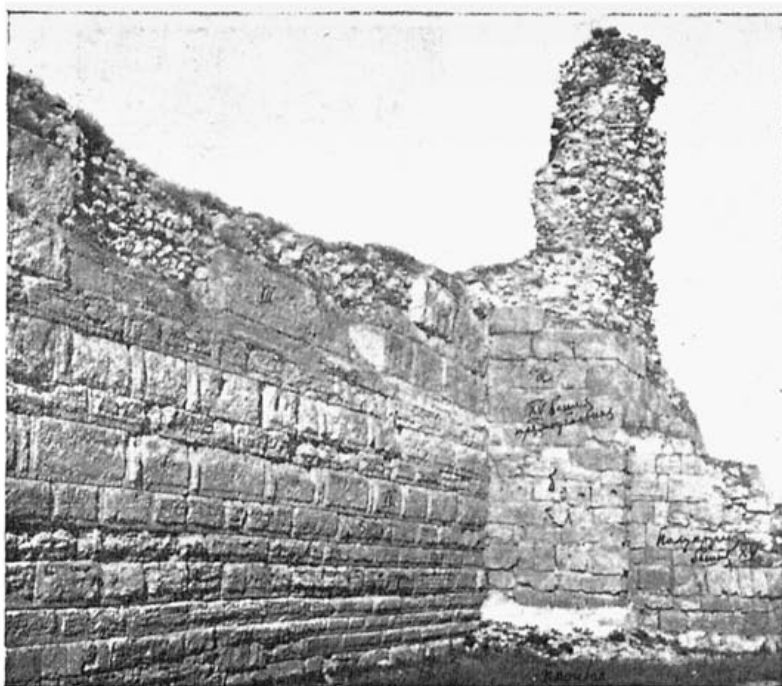
Рис. 14. Часть 16 куртины и комплекс башен № XV: I—III—три яруса кладки; а—лицевая кладка прямоугольной башни № XV; б—фундаментная кладка той же башни.
