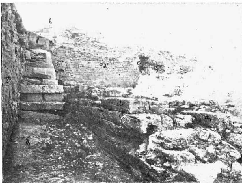
Рис. 66. Кладка II стены 20 куртины (а); б—III стена („аппарель“); в—ядро башни Зенона; г—IV стена; д—19 куртина; е—калитка; а 1 —I стена 20 куртины.
