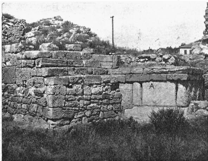
Рис. 84. Утолщения башни № XVI и лестница наверх башни. А—утолщение 2-го яруса кладки 19 куртины; Б—утолщение 3-го яруса кладки византийской эпохи; х—ступени лестницы на башню № XVI; а—б—профилированные камни, замурованные в кладку.
