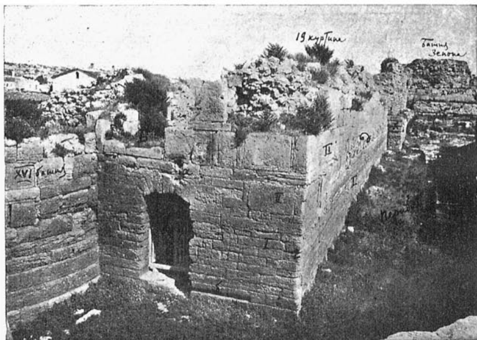
Рис. 80. 19 куртина с перемычки: I, II—два яруса кладки; б—углубление для площадки (?); г—стесанный угол; д—фундамент 2-го яруса; х—утолщение эпохи 3 кольца башни Зенона.
