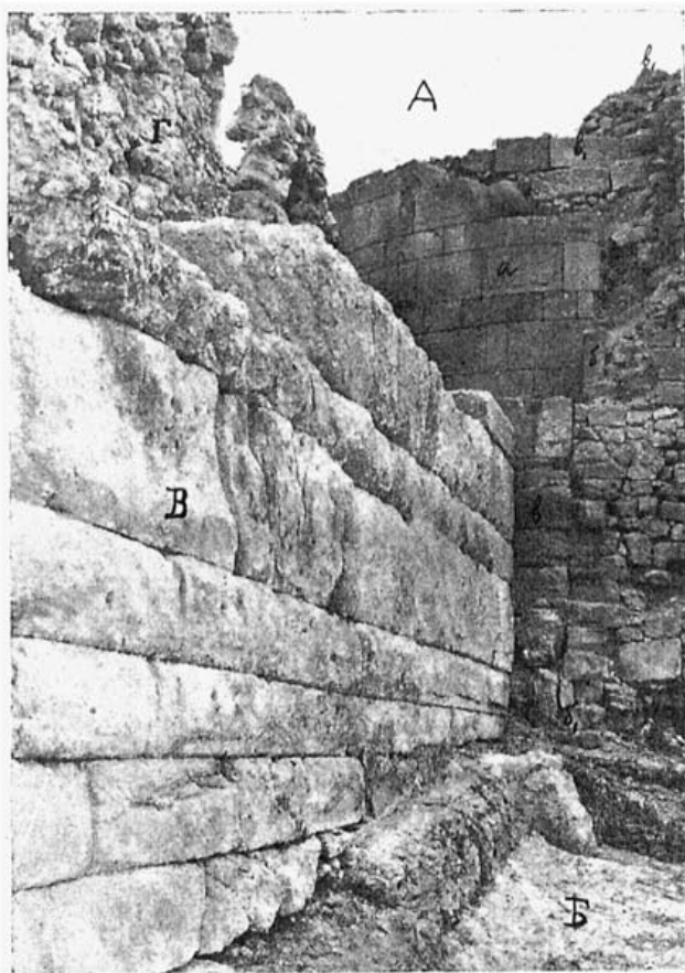
Рис. 71. Место соединения башни Зенона с 20 куртиной: А—башня Зенона; Б—место древнегреческой стены 20 куртины. От нее остались только вырубки в скале; В—III стена, связанная с 1-м кольцом (б); а—ядро; б—отделяющаяся от ядра часть кладки 20 куртины, одновременная ядру; б—б 1 —облом уничтоженной в римское время древнегреческой стены; Г—IV стена, одновременная 2-му кольцу башни Зенона.
