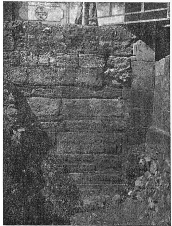
Рис. 7. Кладка конца 15 куртины, соприкасающегося с XIV башней. 1 ярус, считая снизу (6 рядов), — IV в. до н. э., выше — позднеримская кладка. Направо — часть римской прямоугольной башни № XIV.
