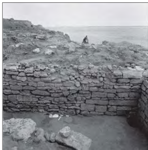
Рис. 11. Подвал № 302. Северная стена.
