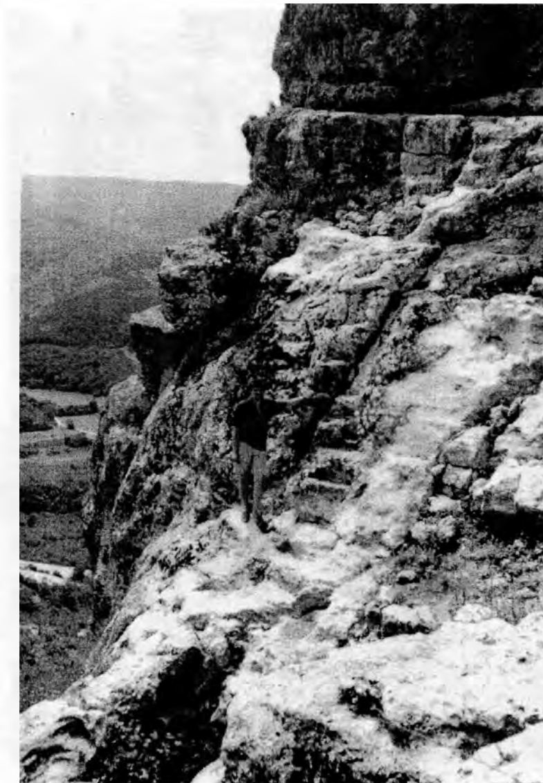
Рис. 5. Скальные подрубки в месте примыкания лицевого панциря стены А.ХІХ на западном склоне расселины Демир-Капу. Сохранившийся фрагмент бутовой кладки верхнего яруса стены. Вид с северо-востока.
