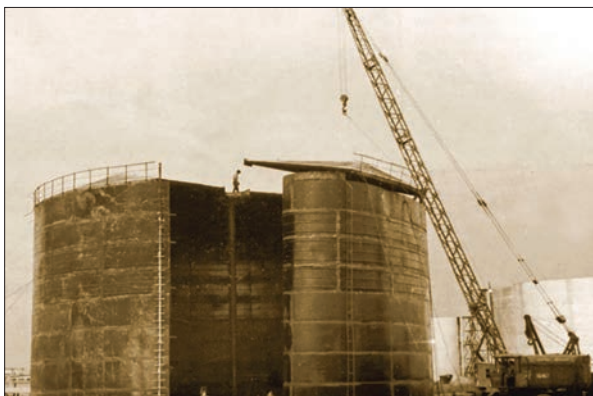
Використання зварювання при спорудженні рулонних резервуарів для зберігання нафти
