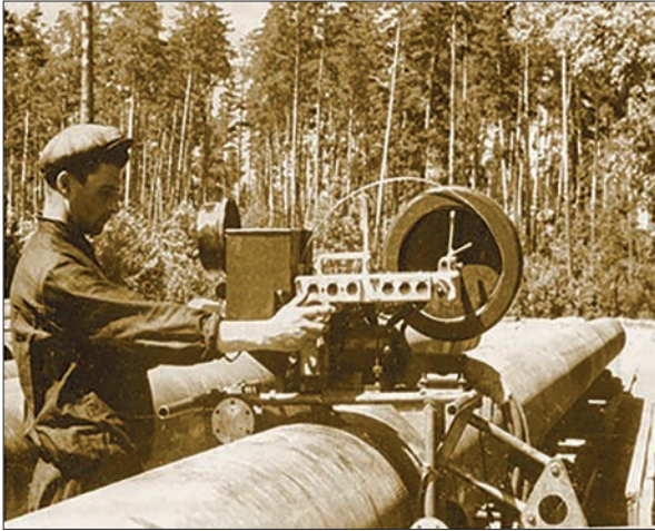
Автоматичне зварювання під флюсом неповоротних стиків труб на будівництві газопроводу Дашава–Київ
