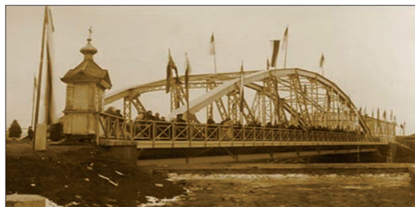
Міст через річку Зушу, побудований за проєктом Є.О. Патона
