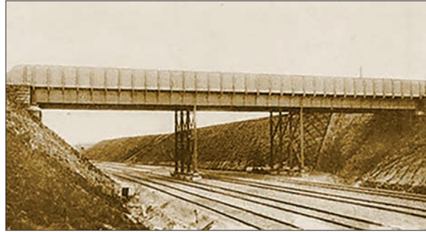
Шляхопровід на станції Москва Ярославської залізниці, побудований за проєктом Є.О. Патона в 1897 р.
