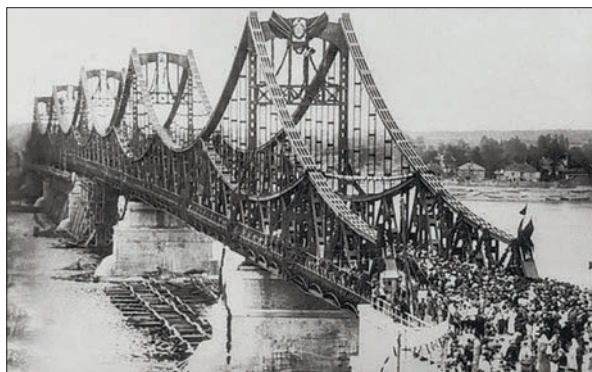
Урочисте відкриття руху на мосту імені Євгенії Бош, побудованому в Києві за проектом Є.О. Патона. 1925 р.
