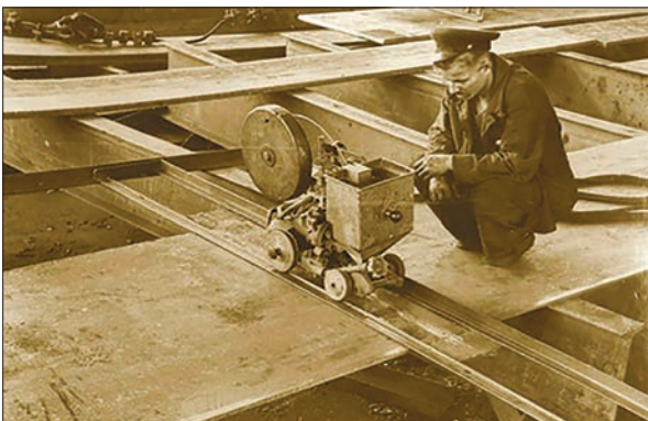
Зварювання балки мостового перекриття на заводі у Дніпропетровську, 1952 р.
