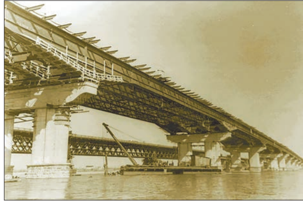
Будівництво суцільнозварного мосту в Києві
