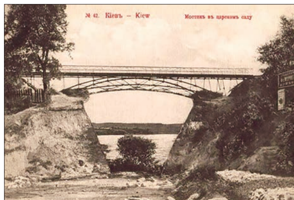
Арковий пішохідний міст, зведений у 1909 р. за проектом Є.О. Патона над Петрівською алеєю в Києві
