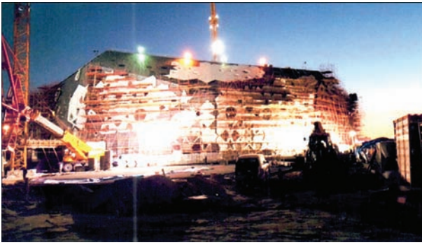
Рис. 9. Строительство культурного центра (вид в вечернее время)
