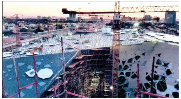
Рис. 11. Монтаж крыши культурного центра
