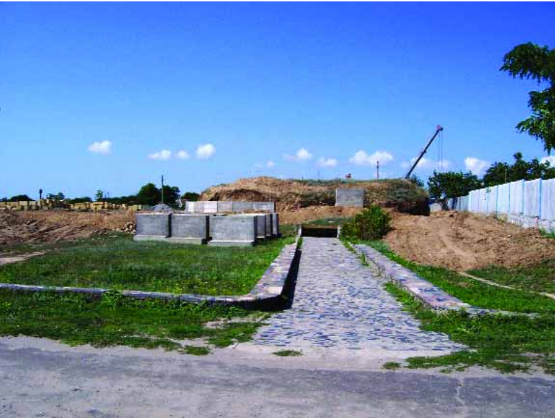
Робочий момент. Залізобетонні блоки підготовлено до монтажу
