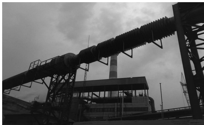
Рис. 3. Радиаторный охладитель газохода колошникового газа
