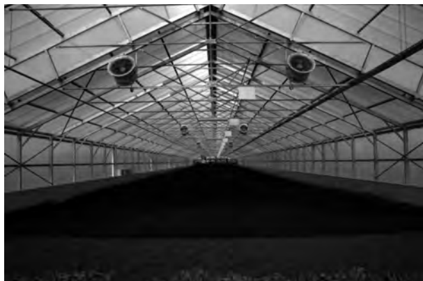
Рис.3. Гібридна сушарка осадів стічних вод.
