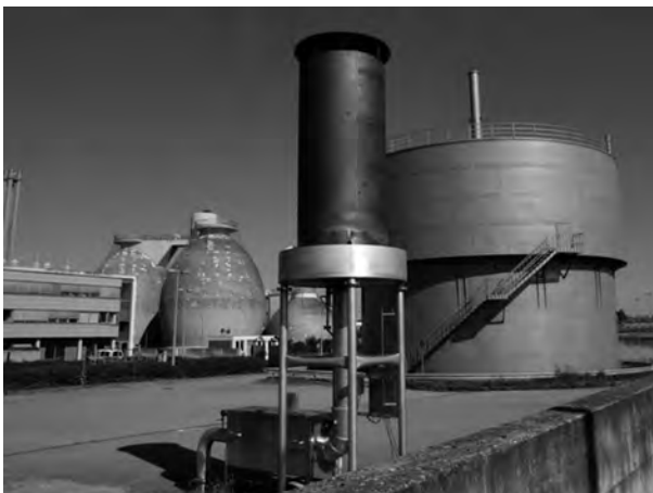
Рис.2. Газгольдер, метантенки та газовий факел у м. Любек (Німеччина) [5]. Фото Entsorgungsbetriebe Luebeck.
