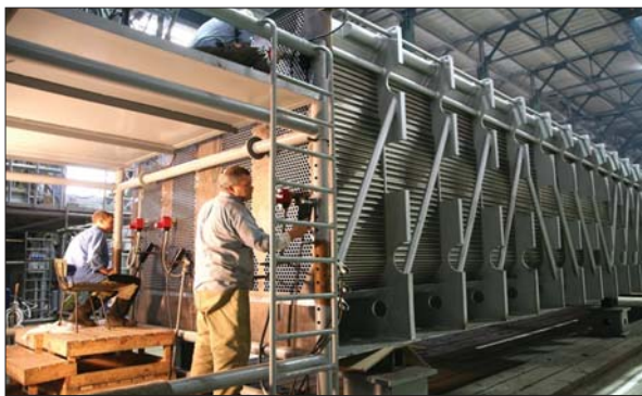
Монтаж охолоджувальних трубок у модуль конденсатора для турбіни К-1000-60/1500-2
