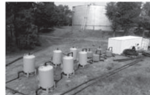
Ліквідація забруднення на пілотному об'єкті у м.Києві
