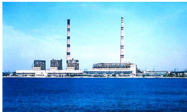
Рис. 6. Общий вид Угледорской ТЭС установленной мощностью 3600 МВт с близлежащим озером-охладителем [4]
