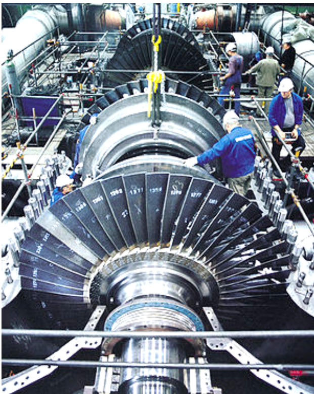
Рис. 4. Общий вид ротора и корпуса современной мощной паровой турбины производства компании «Siemens» (Германия) в процессе ее монтажа на рабочей площадке ТЭС [9]
