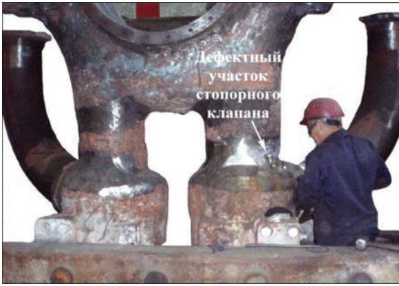
Рис. 2. Крышка ЦСД со стопорными клапанами при подготовке к ремонту
